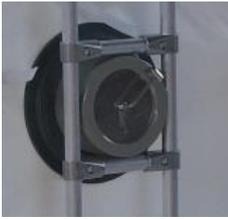
automatische Unterdruckklappe (Gewichts-betätigt), zur Aufrechterhaltung eines stabilen Unterdruckes (Artikelnummer 110785)
